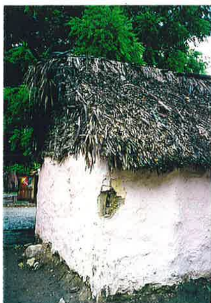
写真8 土塗りの大壁造の建物も残っている。現在は住宅には使われていない。
