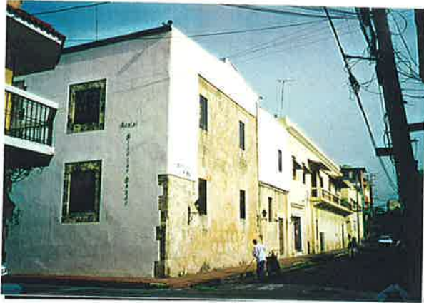
写真1 民家を再生した Hostal Nader. 1階の角の右の窓の部屋に泊まりました。
